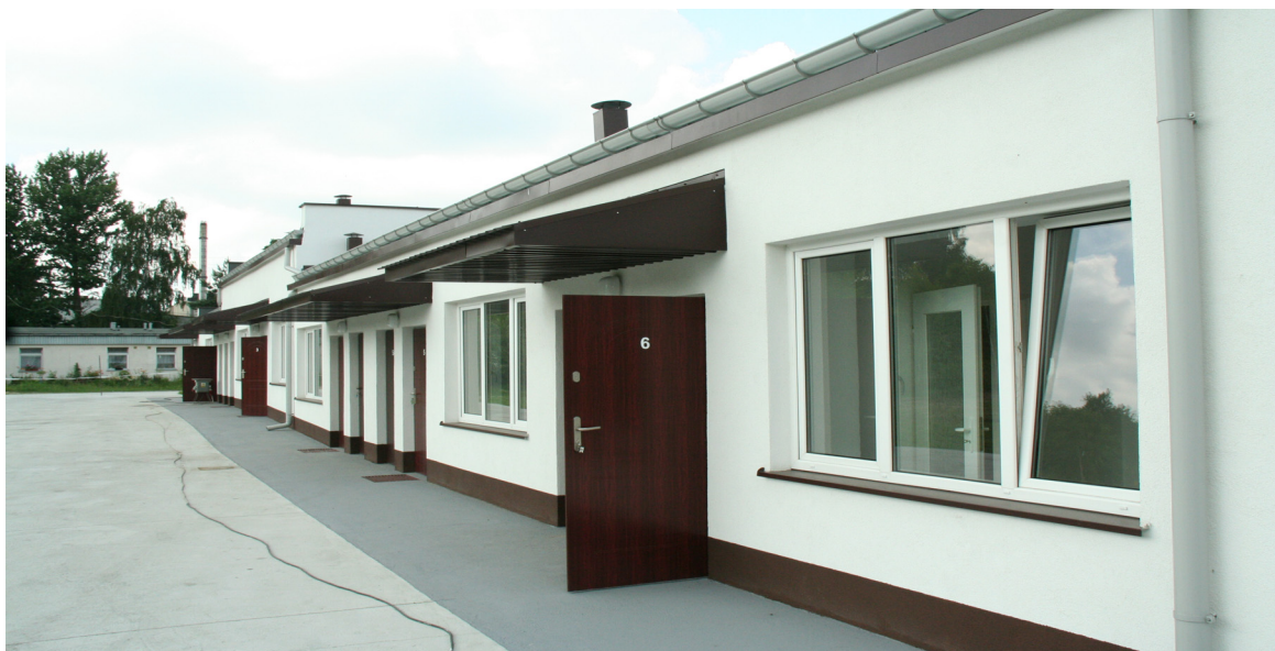
Przebudowa pomieszczeń warsztatowych na lokale socjalne w Głownie
